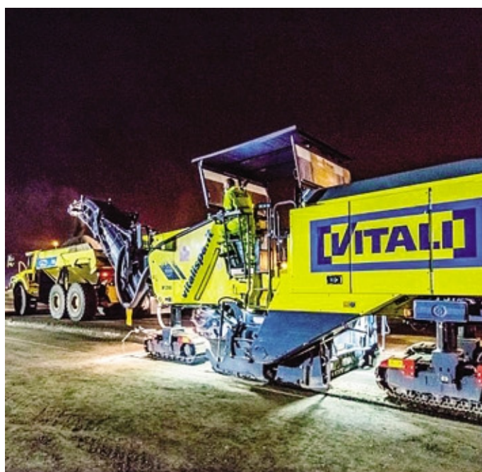
I mezzi del gruppo Vitali al lavoro sulla pista di Milano Malpensa
